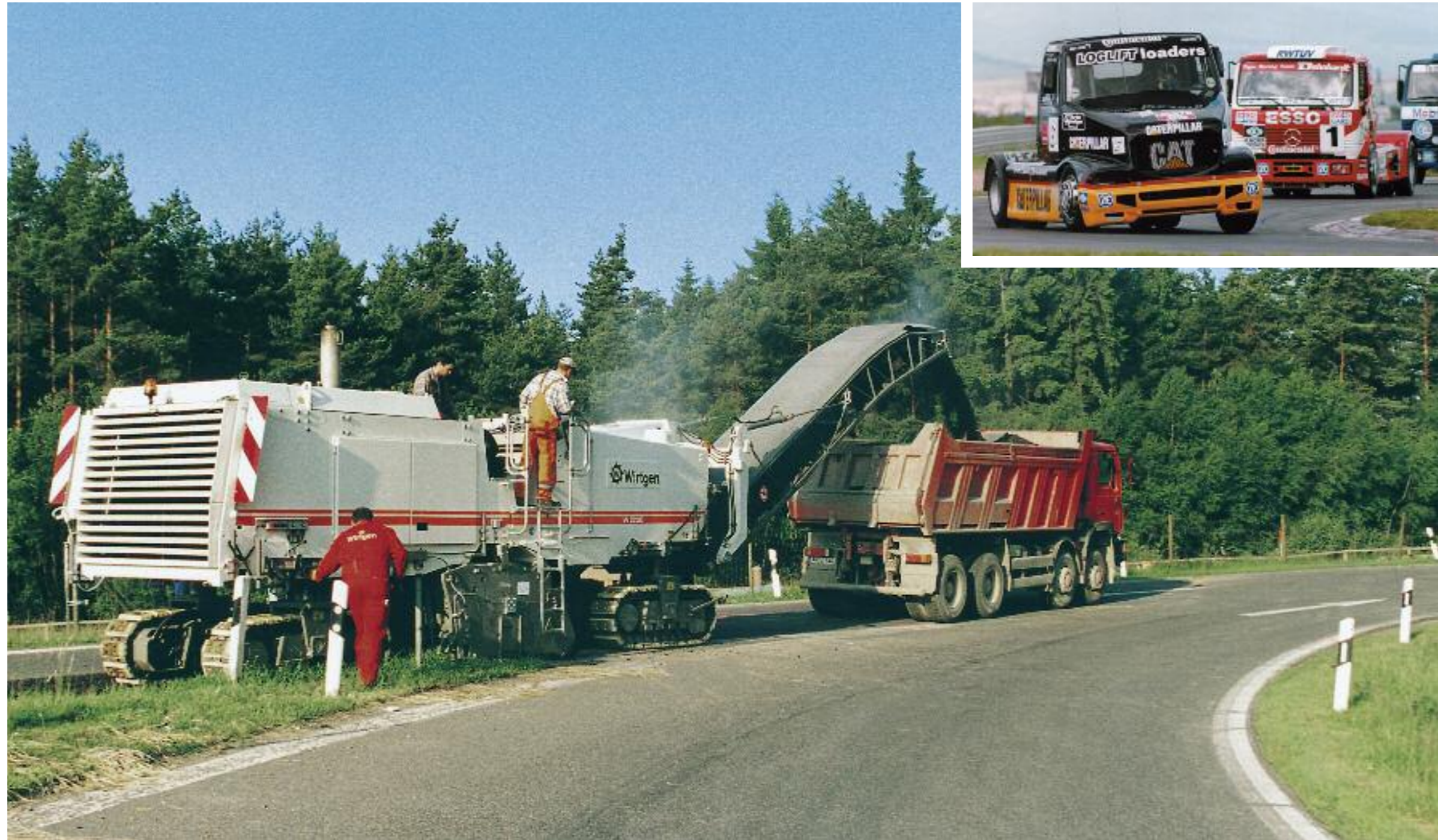
Straßenfräse mit Caterpillar Motor: einer von vielen Einsatzbereichen in der Bauindustrie
