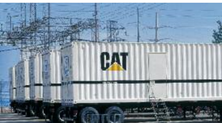
Stromaggregate: ideal für Spitzenlastabdeckung und Überbrückung
